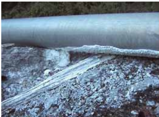
Соляной «куржак» (выцветы солей) на трубах от испарений Гаргинского термоминерального источника. Фото В.В. Тахтеева
